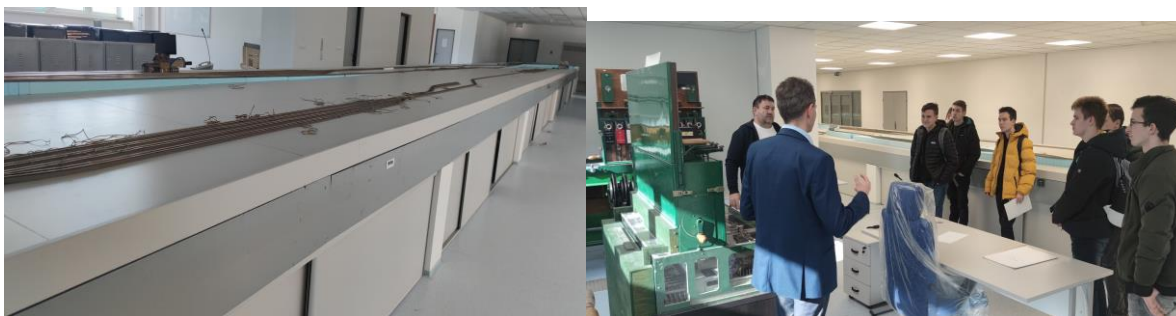
Obr. 7. Pohľad na budované dopravné laboratórium a inštruktáž študentov pred testovaním
