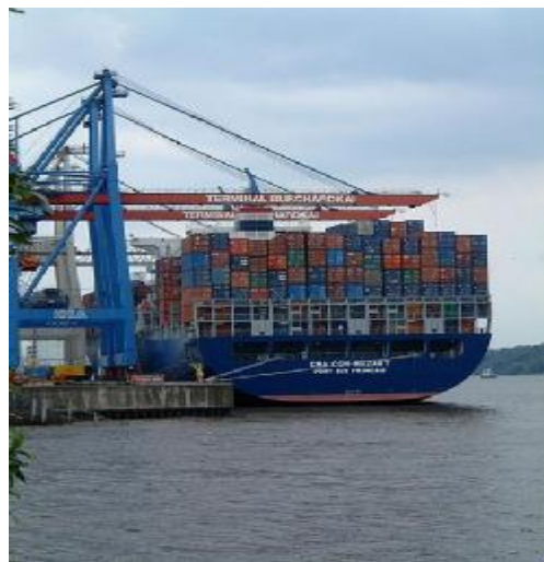
Obr.1 Kontajnerový terminál Burchardkai
