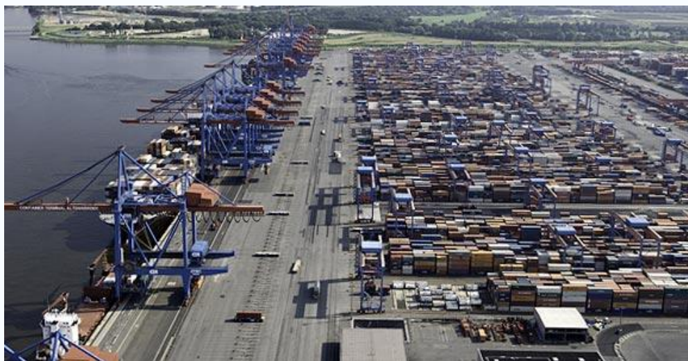
Obr.2 Kontajnerový terminál Alterwerder
