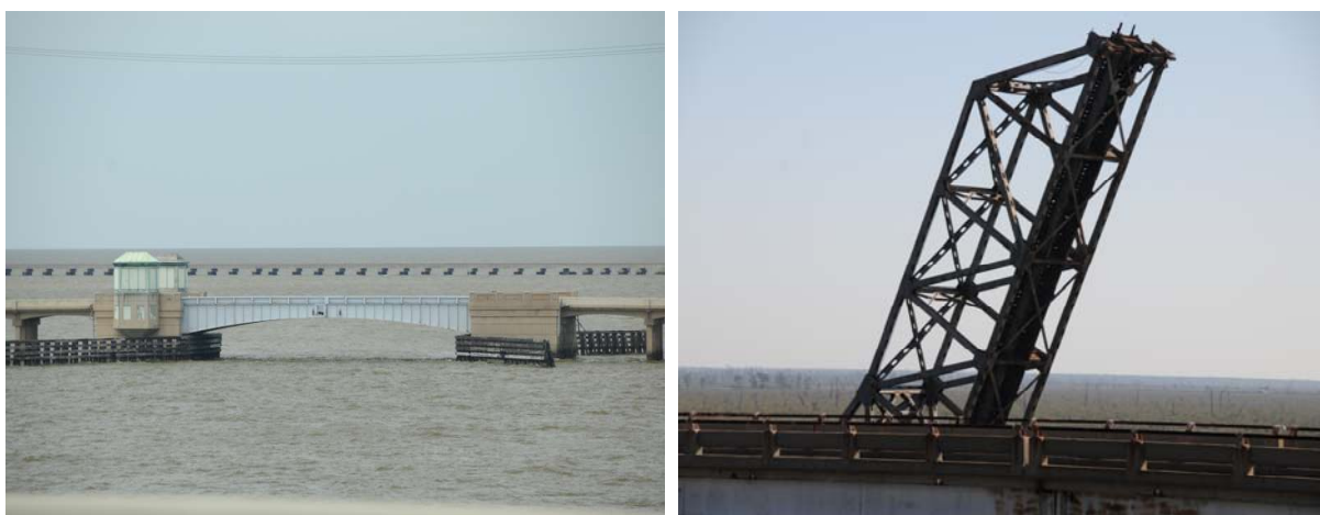
Obr.3 Zdvihací mosty na železniční trati v deltě Mississippi
